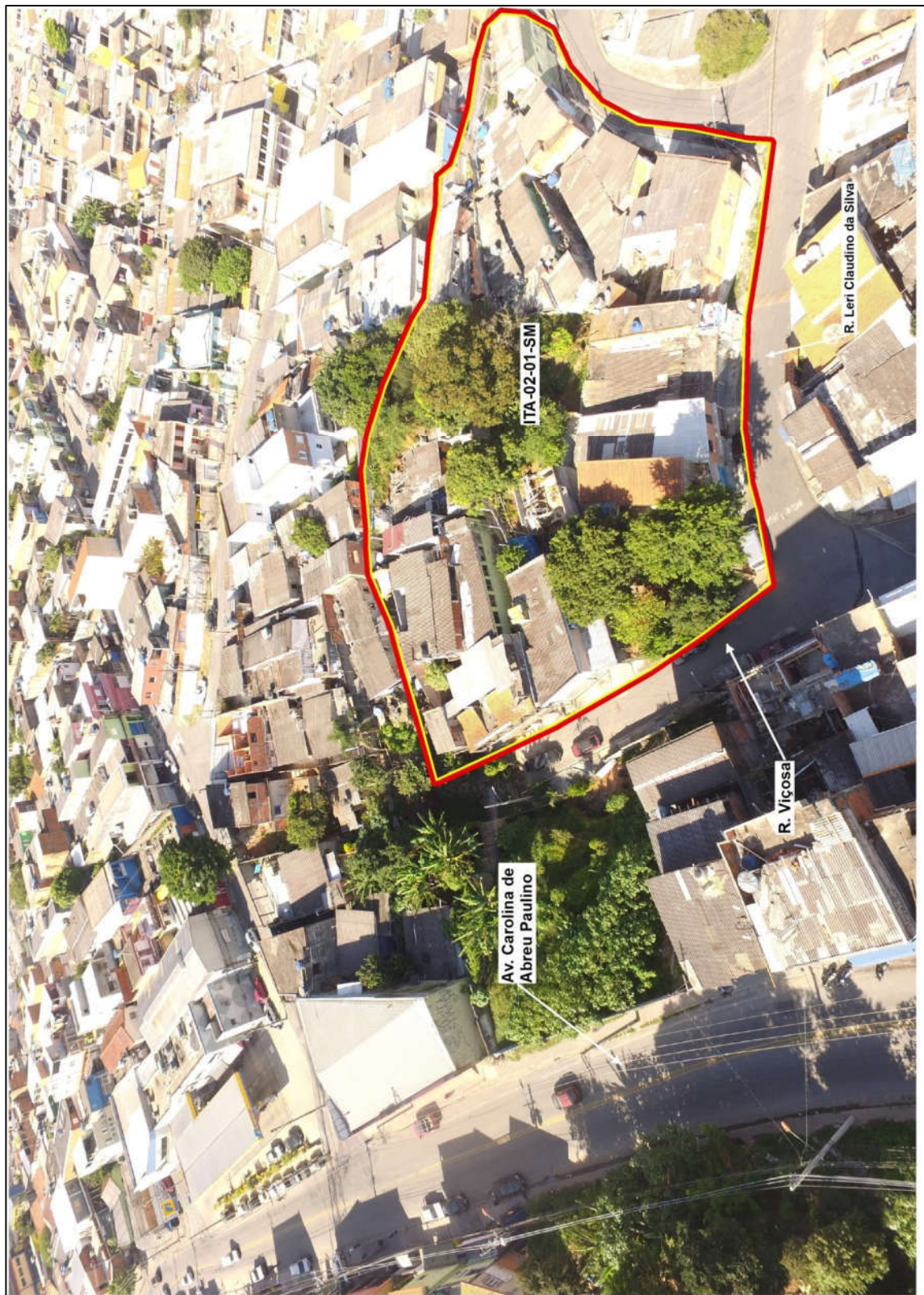
Foto FH-ITA-02.01: Vista do setor mapeado.
