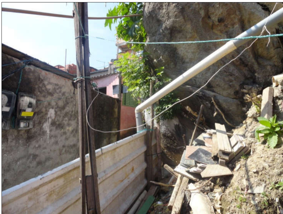
Foto FC-ITA-01-01-02.03: Base do bloco de rocha (matação) que sustenta as caixas d'água. Notar a proximidade com as moradias do entorno.
