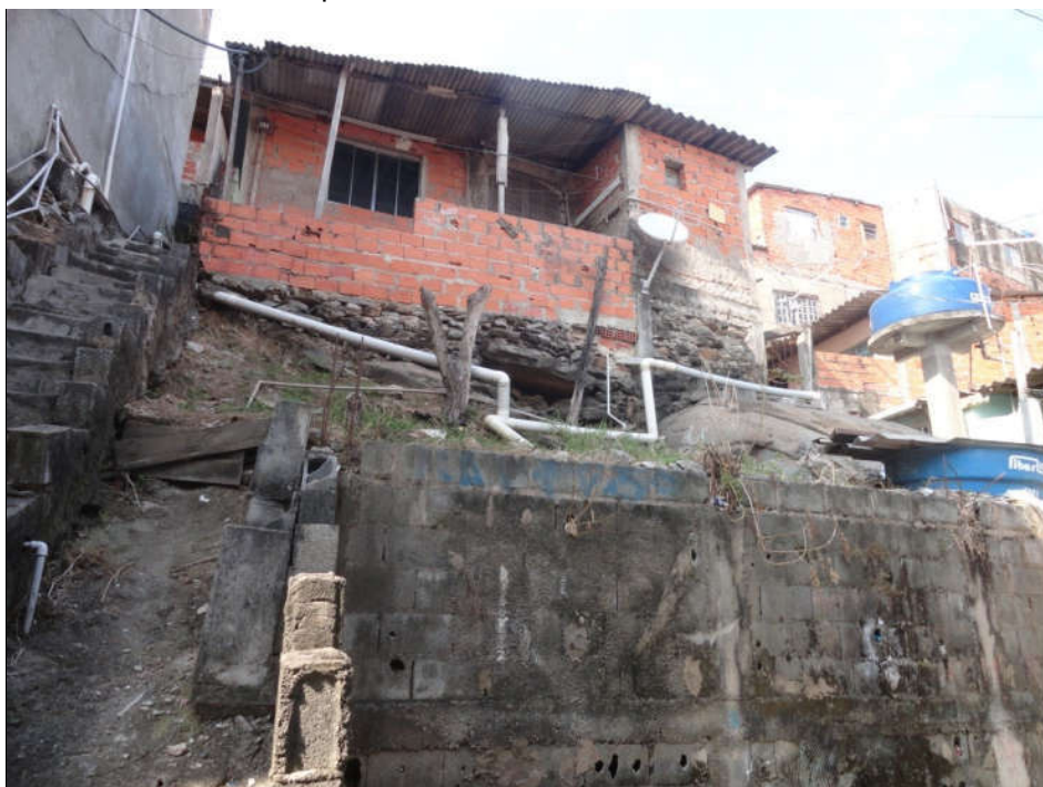
Foto FC-ITA-01-01-01.02: Detalhe do talude com muro de contenção e moradia a montante, ambos estáveis.
