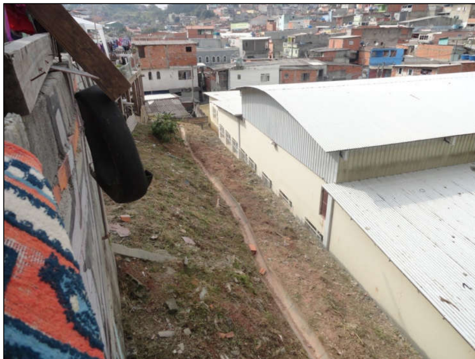
Foto FC-ITA-03-01.02: Trecho do setor mostrando nos fundos da escola com o retaludamento e muro de gabião. Ao fundo notar as outras moradias do setor.
