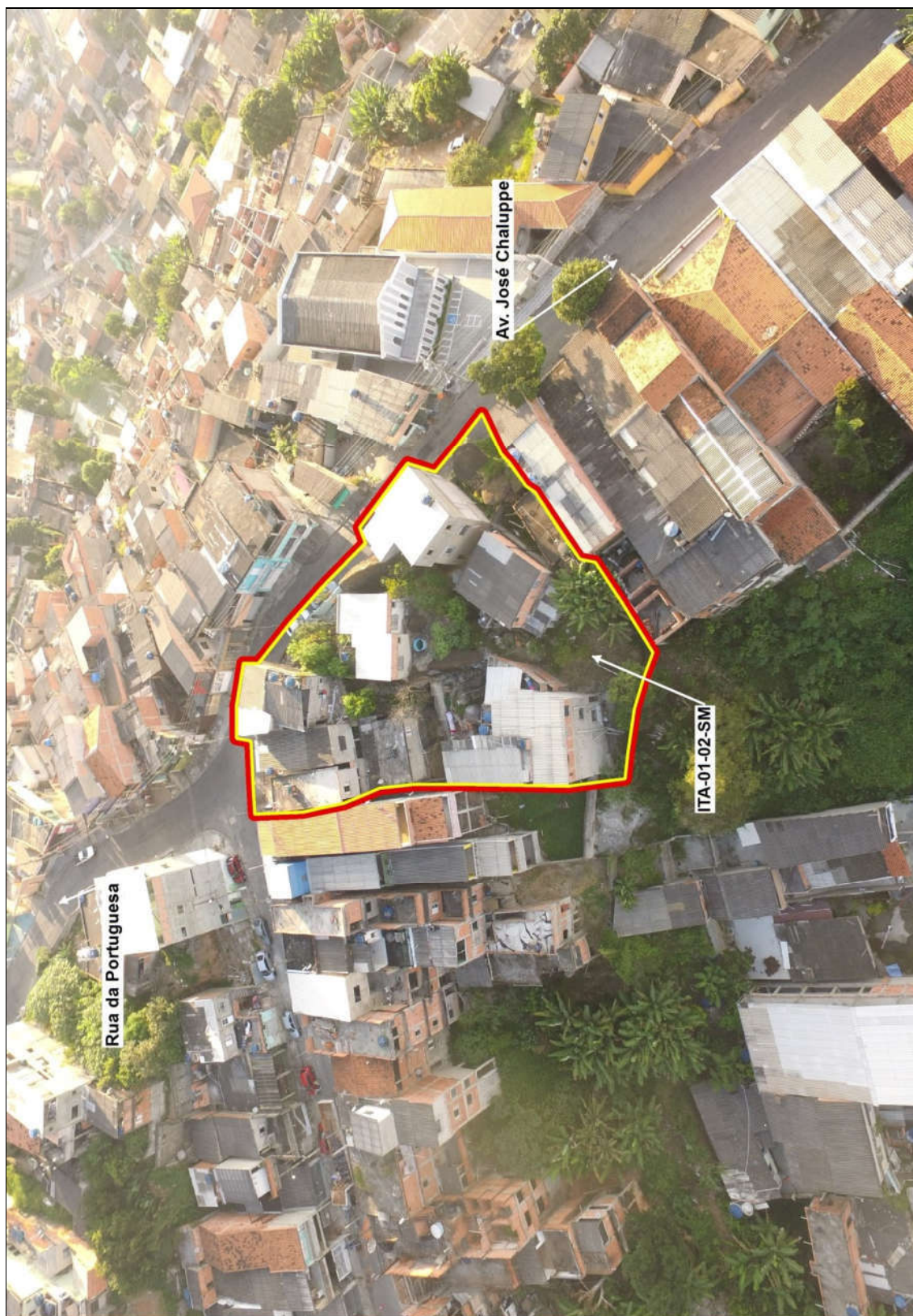
Foto FH-ITA-01.02: Vista do setor mapeado.
