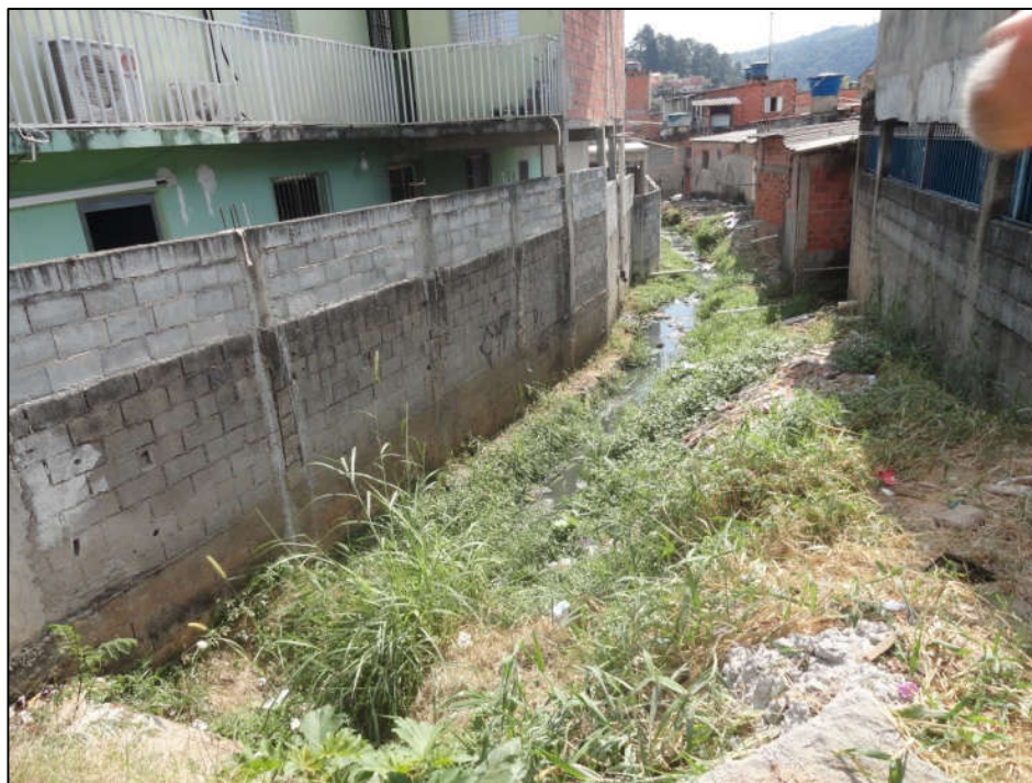
Foto FC-ITA-01-04.03: Vista do córrego com moradia ao lado do canal.
