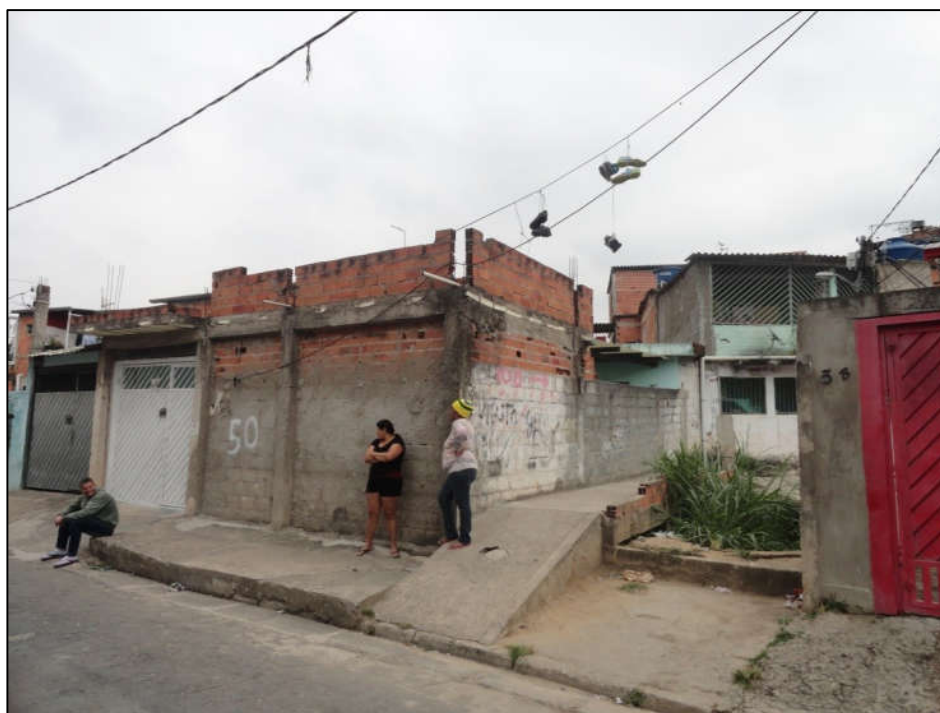
Foto FC-ITA-03-02.04: Vista do córrego mostrando as moradias tamponando o canal. O córrego pode ser visto apenas onde se encontra a vegetação próxima ao centro da foto.
