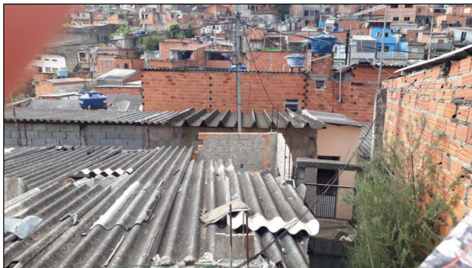
Foto FC-ITA-01-07-02.03: Vista dos telhados das moradias mostrando o grande adensamento da ocupação.
