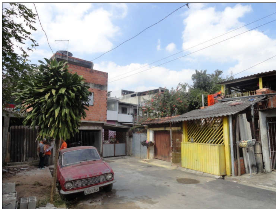
Foto FC-ITA-01-04.04: Vista de moradias que estão construídas sobre o canal.
