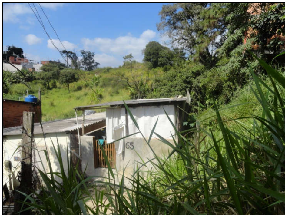
Foto FC-ITA-01-07-01.02: Detalhe da única moradia este setor com talude de corte atrás.
