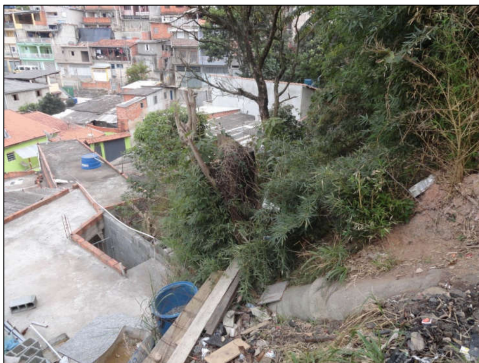
Foto FC-ITA-02-01.04: Detalhe do talude de corte mostrando no centro da foto a tubulação de drenagem de águas pluviais.
