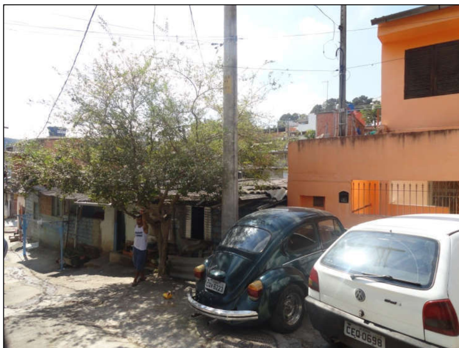
Foto FC-ITA-01-06.04: Vista de moradias que estão construídas sobre o canal.
