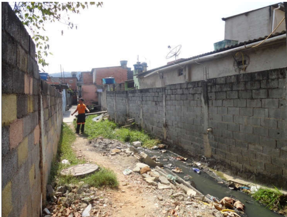
Foto FC-ITA-01-03.04: Vista do córrego mostrando as moradias ocupando as margens. Notar poço de visita da rede de esgotos do lado esquerdo da foto.
