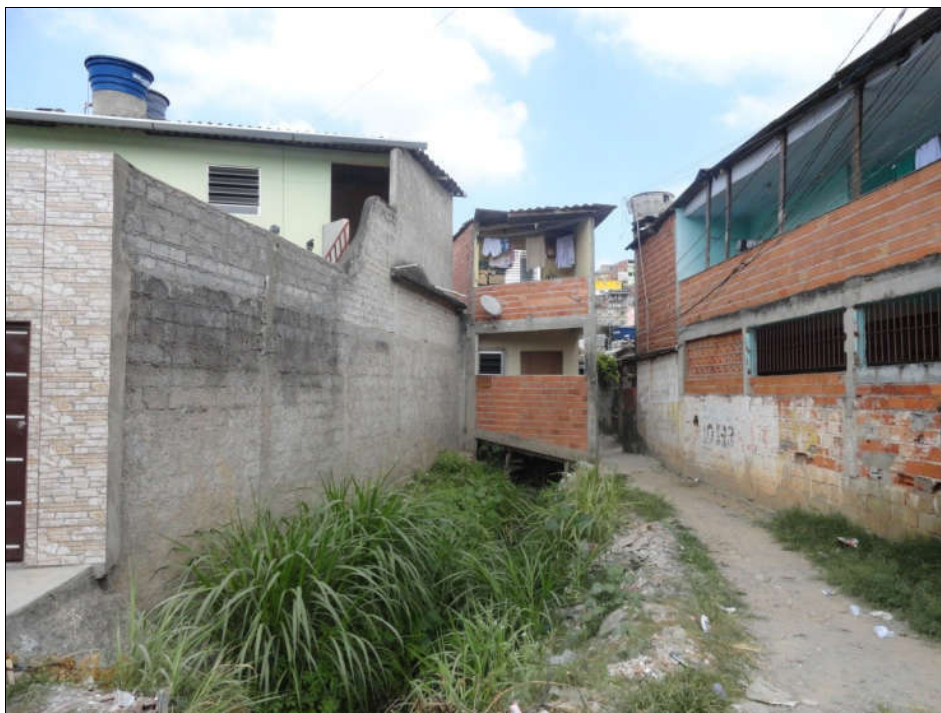
Foto FC-ITA-01-03.03: Vista do córrego com moradia sobre o canal.
