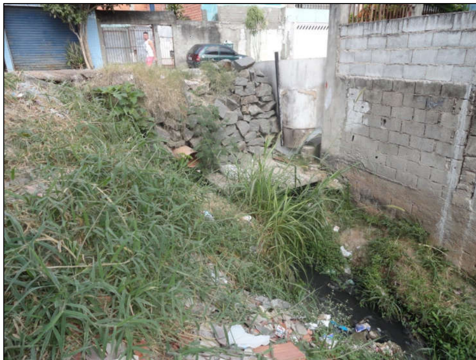
Foto FC-ITA-01-06.01: Vista da travessia de rua construída com blocos de rocha. Notar a altura do talude marginal do córrego.
