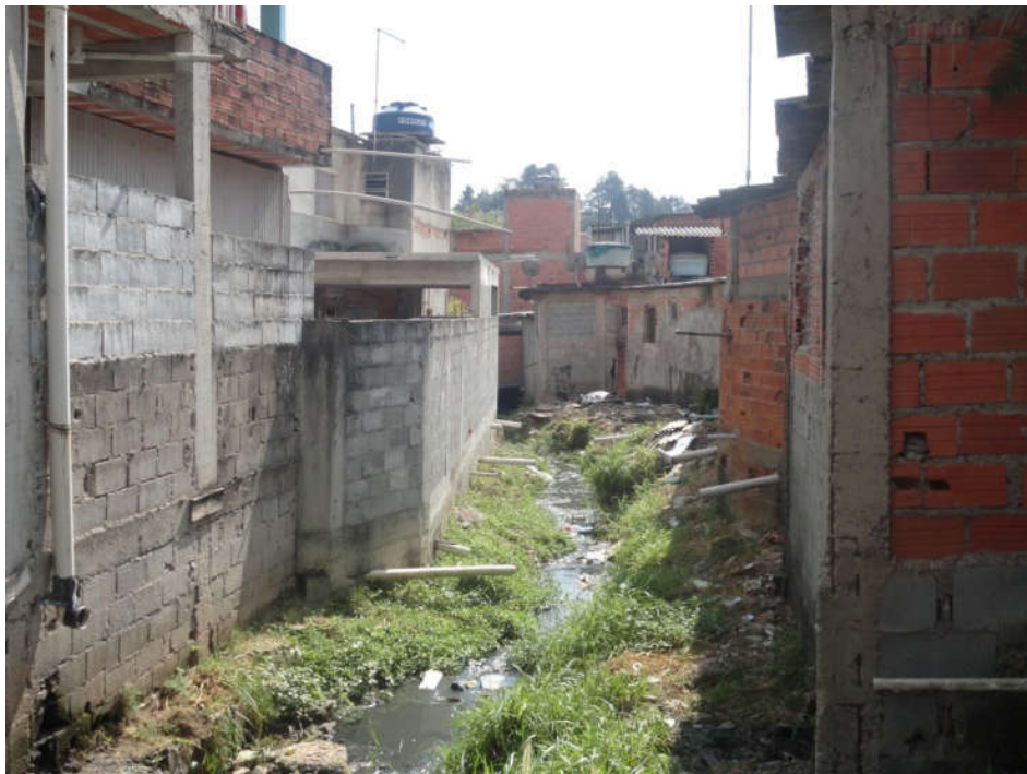
Foto FC-ITA-01-04.02: Detalhe do córrego com margens ocupadas por moradias e com vegetação dentro do canal. Observar a grande quantidade de tubos que lançam águas pluviais e esgoto no córrego.
