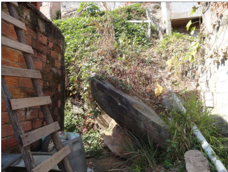
Foto FC-ITA-01-01-03.02: Detalhe de dois blocos de rocha embarralhados na lateral do terreno e na base do talude de corte. Notar a proximidade com a moradia.
