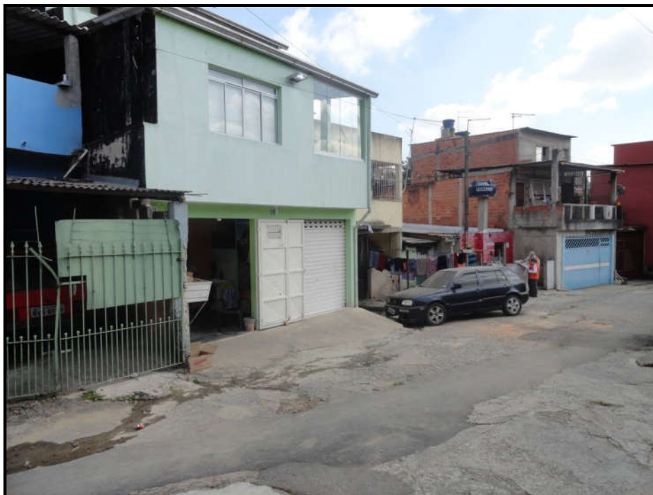
Foto FC-ITA-01-05.01: Vista da rua onde no meio está o córrego completamente tamponado.
