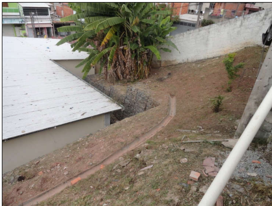
Foto FC-ITA-03-01.03: Trecho do retaludamento e muro de gabião com destaque para a drenagem do aterro.
