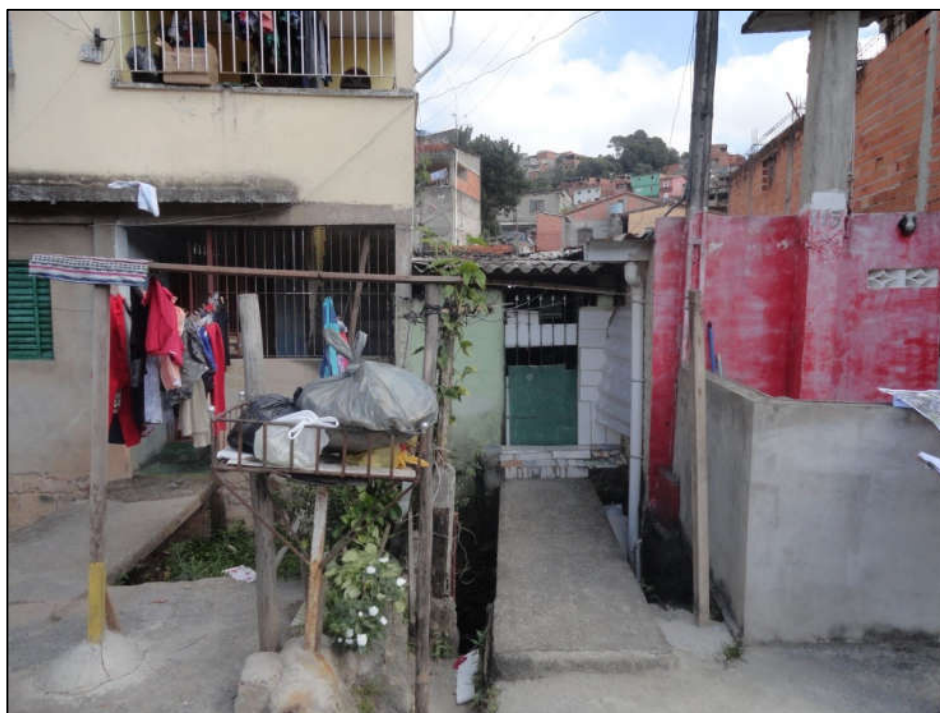
Foto FC-ITA-01-05.04: Vista de moradias que estão construídas sobre o canal.
