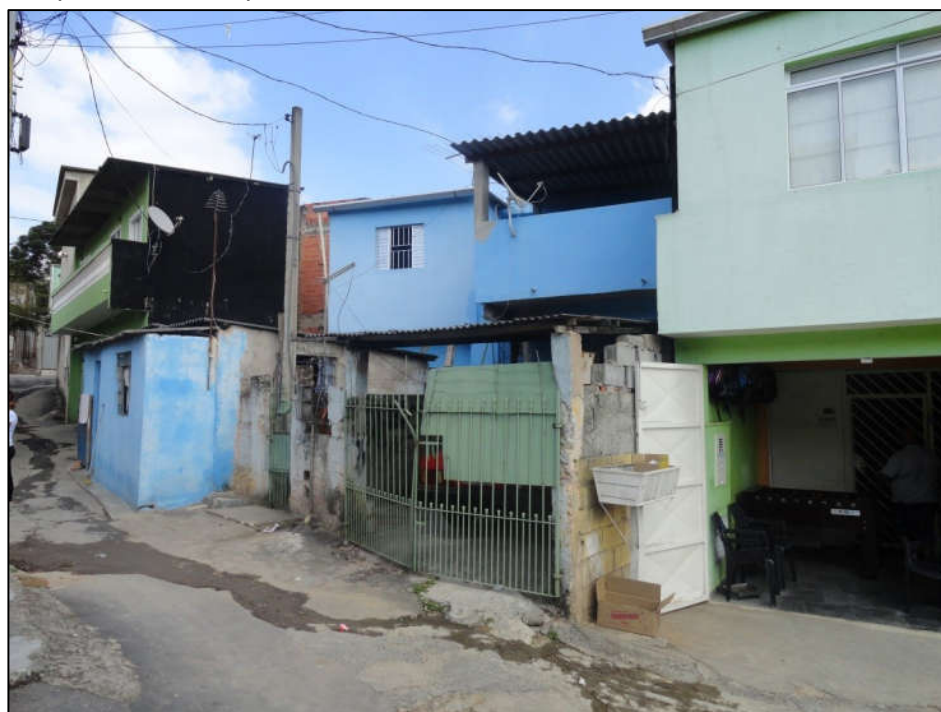
Foto FC-ITA-01-05.02: Detalhe da rua sob a qual corre o córrego aqui completamente tamponado.
