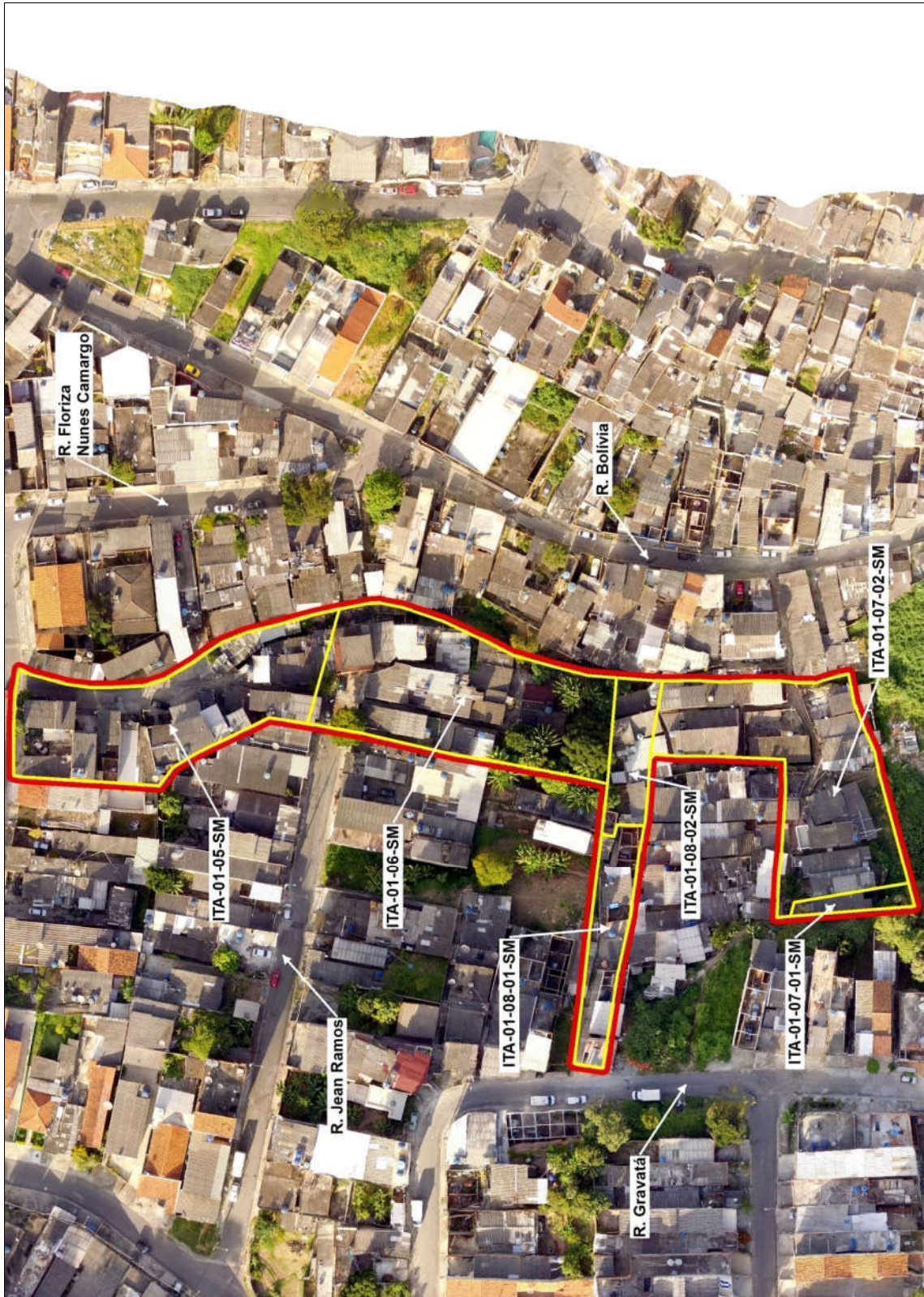
Foto FH-ITA-01.04: Vista do setor mapeado.
