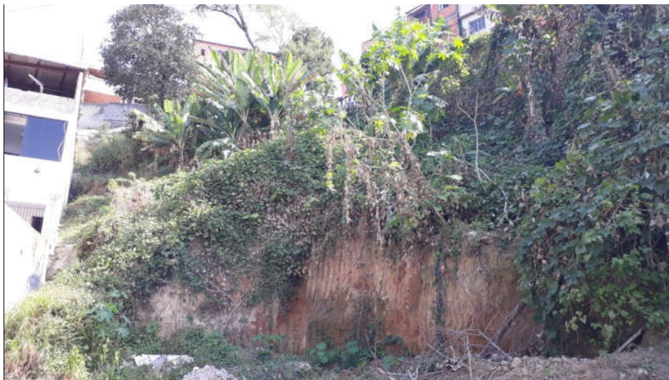
Foto FC-ITA-01-02.04: Talude de corte localizado na base da encosta já em frente à rua Vitória de Santo Antão.
