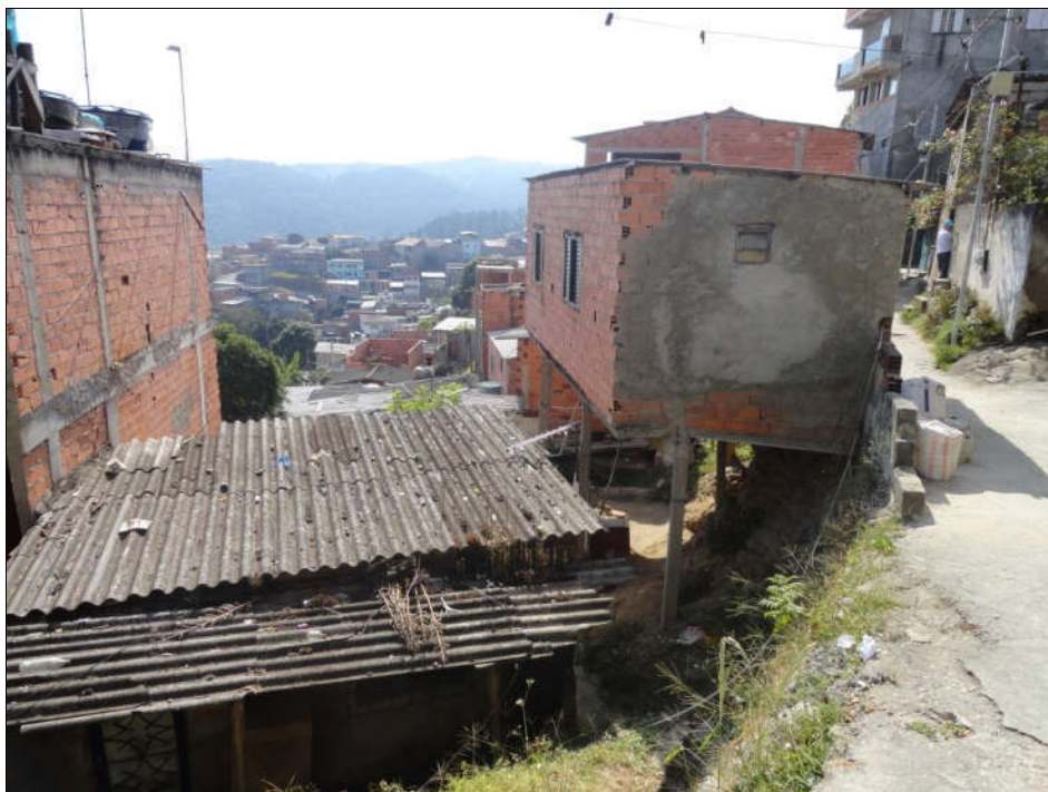
Foto FC-ITA-01-01-01.03: Situação de moradia com padrão construtivo em pilotis.
