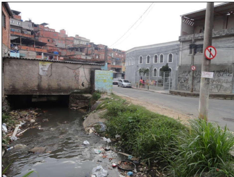
Foto FC-ITA-03-02.01: Vista do córrego com moradia tamponando o canal.
