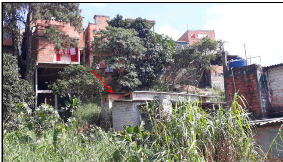
Foto FC-ITA-01-07-01.01: Vista do setor compreendido por apenas uma pequena moradia que está no centro da foto, mostrada na seta vermelha.
