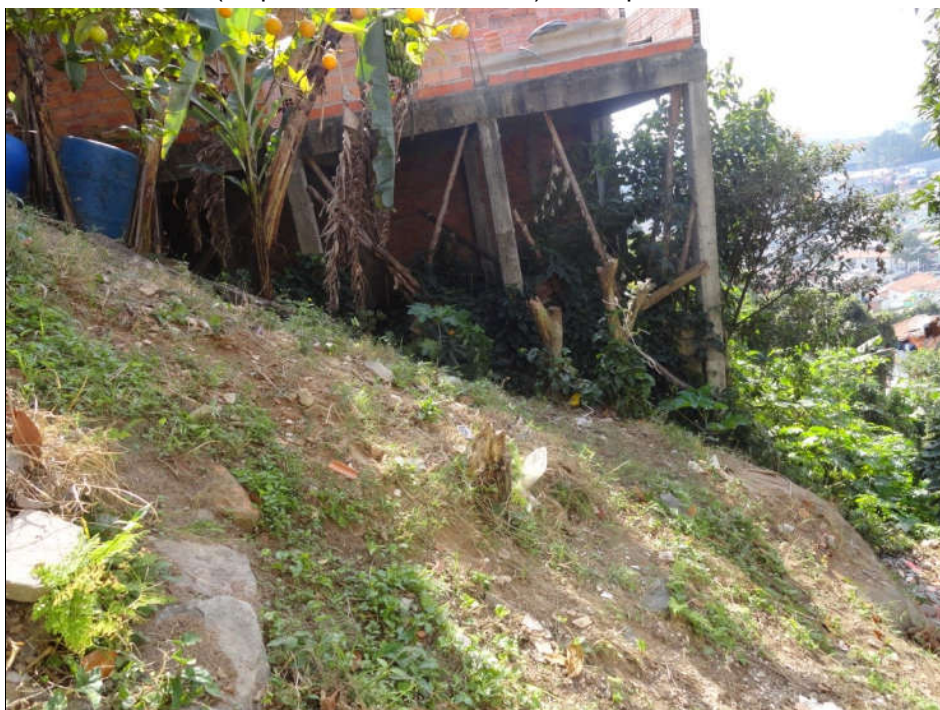
Foto FC-ITA-01-02.02: Detalhe do talude com aterro. Notar no canto inferior esquerdo pequeno bloco de rocha imerso no solo.
